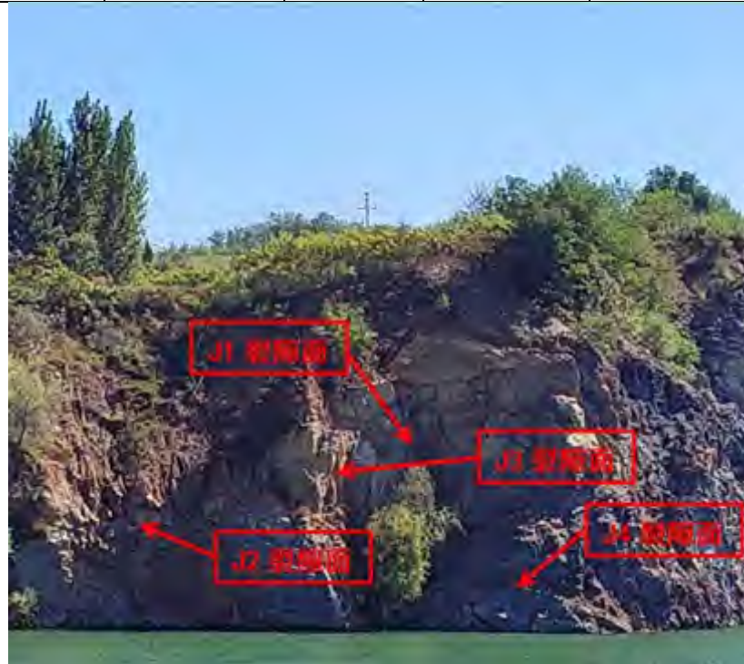
图3-8 3#矿坑岩体裂隙面状况
